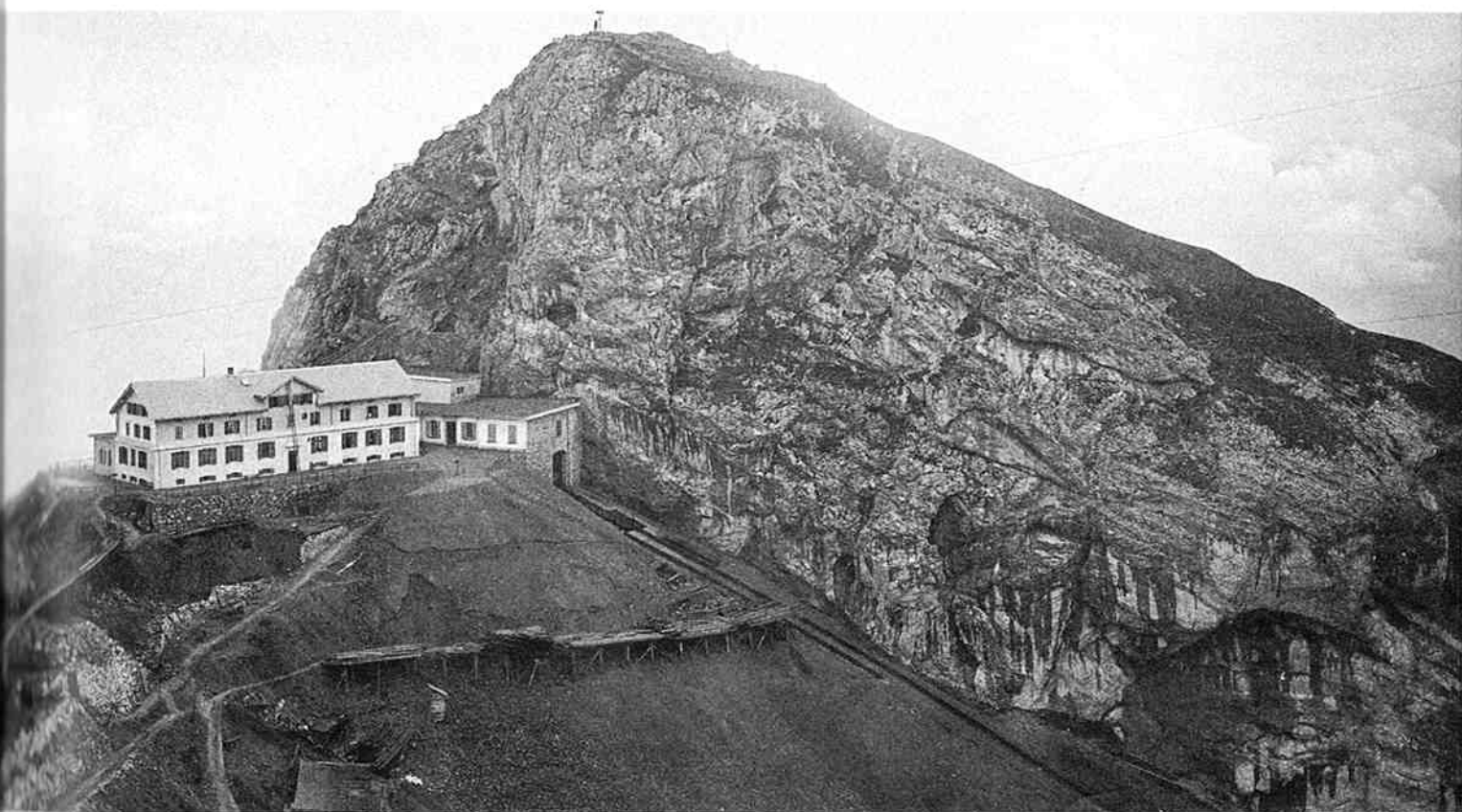
Bau der Station Pilatus Kulm neben dem alten Hotel Bellevue
