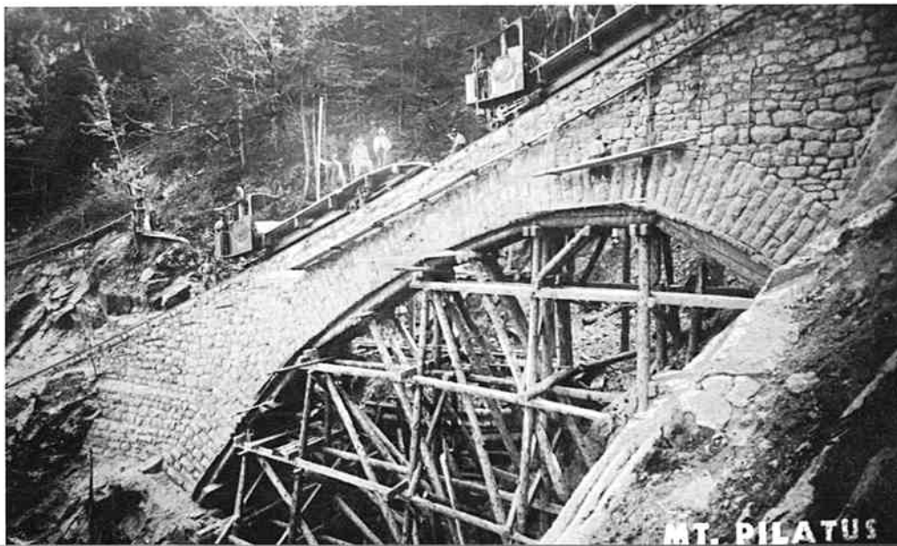
Bauarbeiten an der Wolfortbrücke
